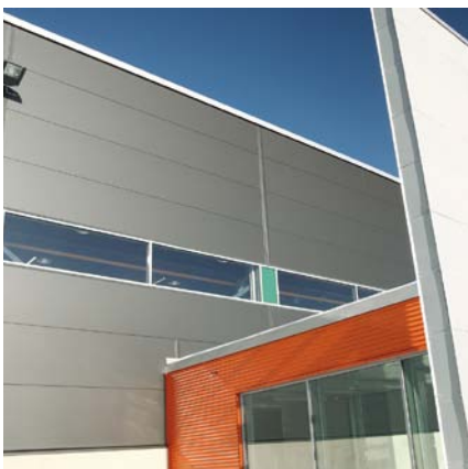
Metson teollisuusventtiilitehdas, Vantaa, julkisivujen eristyslasit
